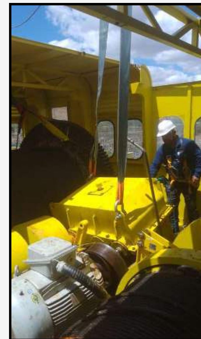
Inspeção e Manutenção em Motores
