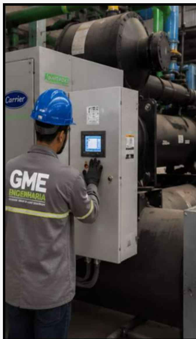
Manutenção em Chillers Industriais
