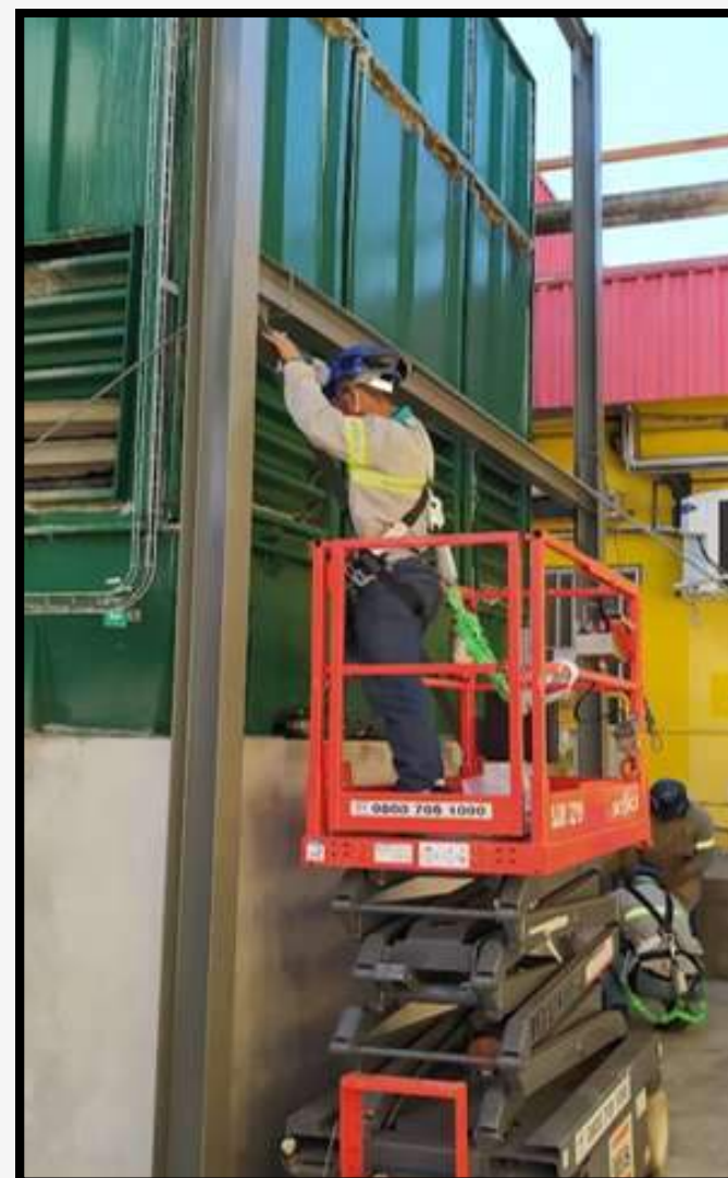
Recuperação de Estrutura de Torre de Resfriamento
