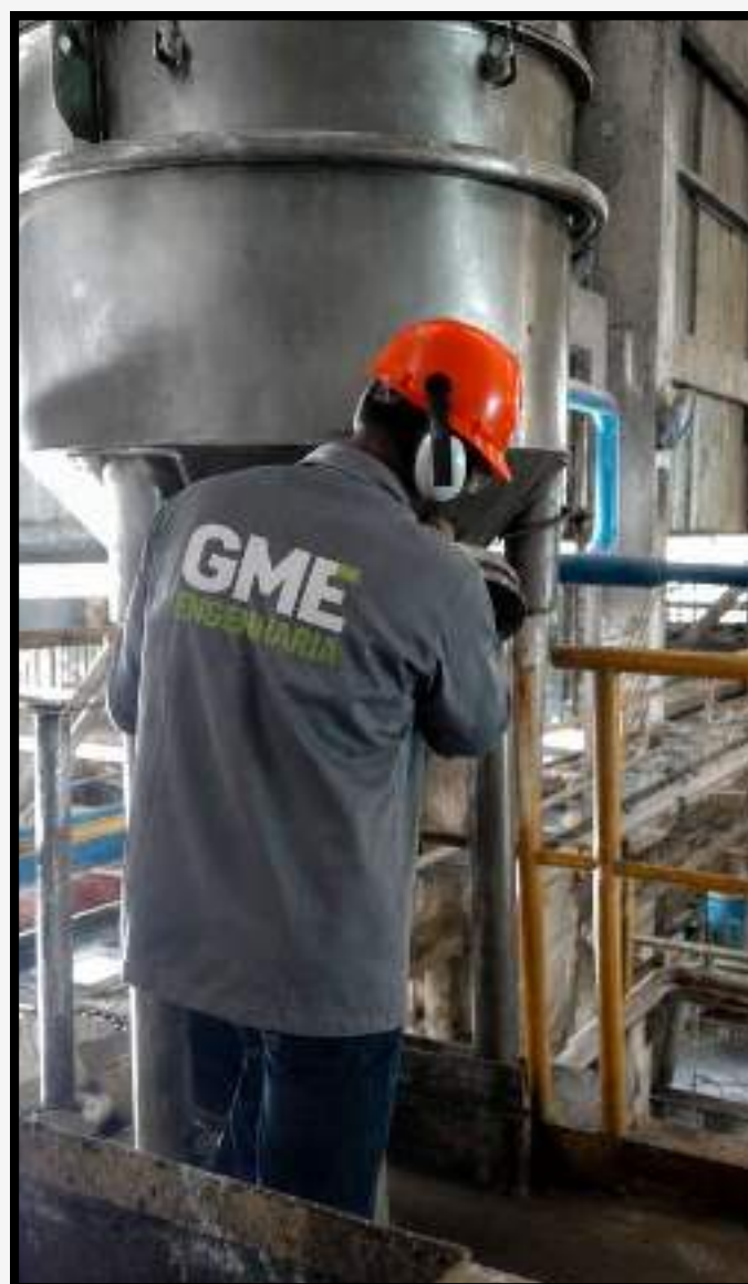
Inspeção e Montagem de Ciclones Industriais
