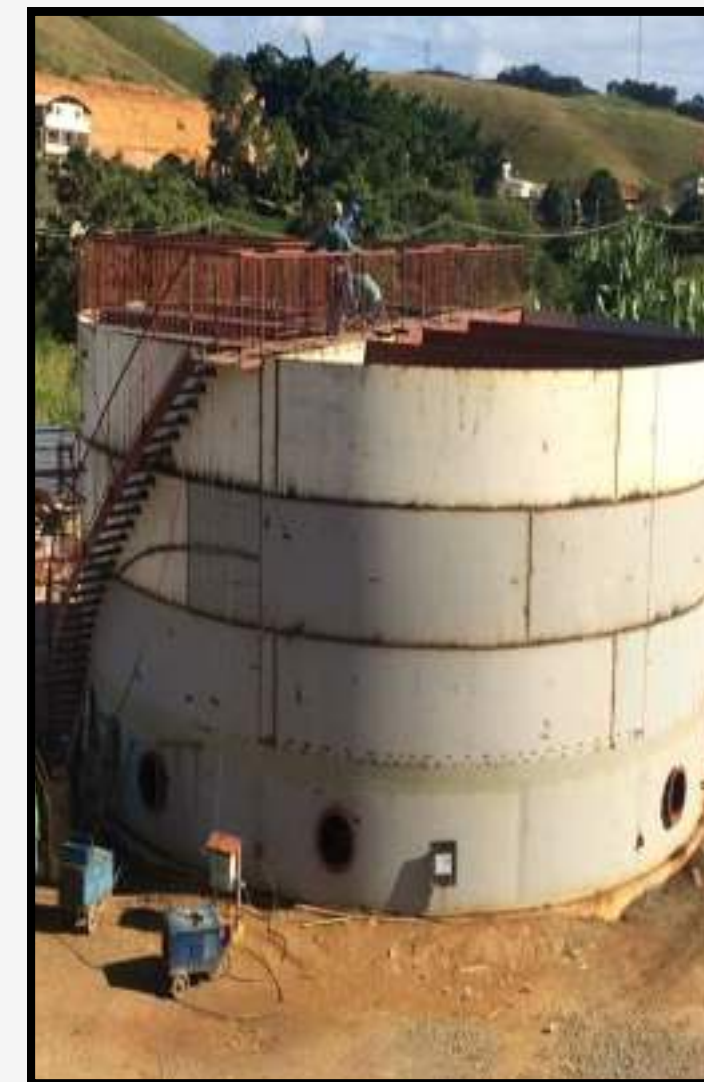
Fabricação, Montagem e Reparos de Tanques
