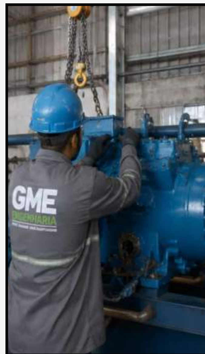
Substituição de Compressores em Chillers
